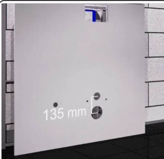
Установите металлический профиль, а затем гипсокартон, заранее разметив все нужные отверстия.
