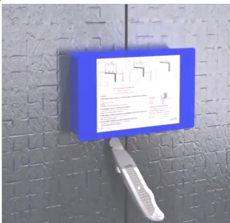
Отрежьте лишнее для подготовки монтажа смывной кнопки.
