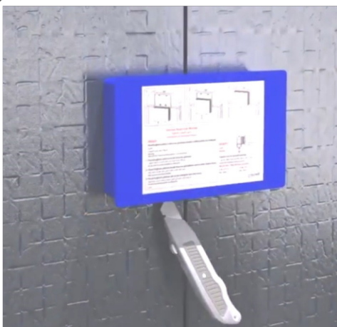
Отрежьте лишнее для подготовки монтажа смывной кнопки.
