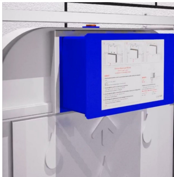
Установите защитную крышку.
